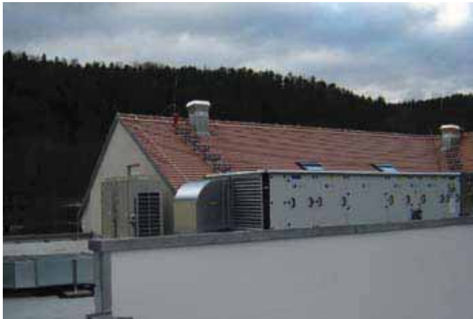
Bild 13: Aufstellung eines Zentrallüftungsgerätes auf einem Flachdach
