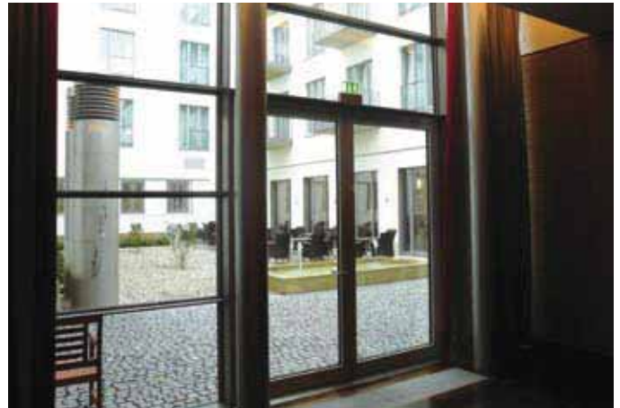
Bild 14: Lufttürme für Frischluft des Veranstaltungssaals
