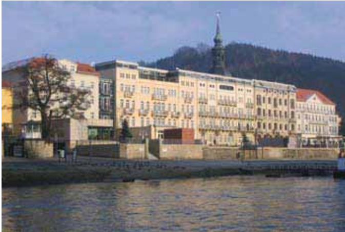
Bild 1: Elbseitige Ansicht des Hotels Elbresidenz
