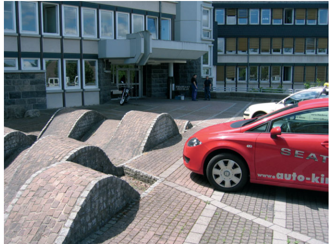
Bild 1. Freideck der Tiefgarage
