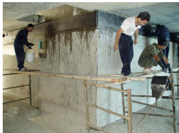
Bild 5: Schubverstärkung von Wänden mit Carbonfasern
