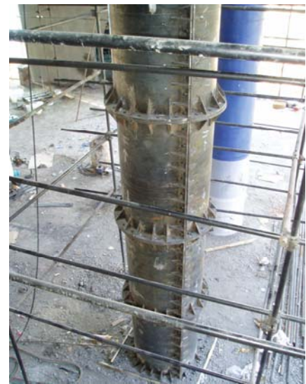
Bild 7: Stahlbetonstütze mit Stahlmanschette
