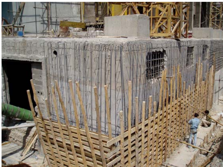
Bild 6: Wände mit Verbundankern für Vorsatzschale
