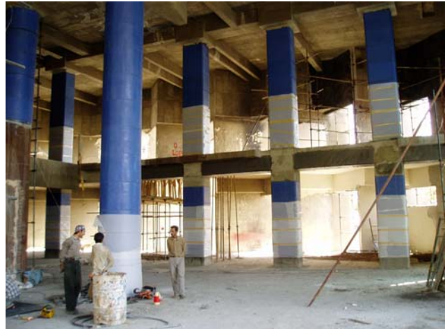
Bild 9: Stahlbetonstützen mit Glasfaserumschnürung
