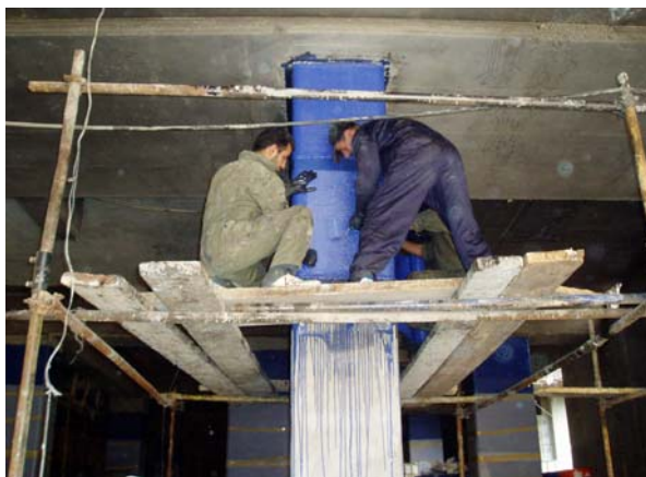
Bild 4: Umwicklung von Stützen mit Glasfasern
