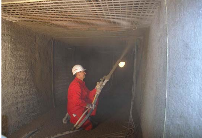
Bild 1: Anwendung von Spritzbeton zur Verstärkung
